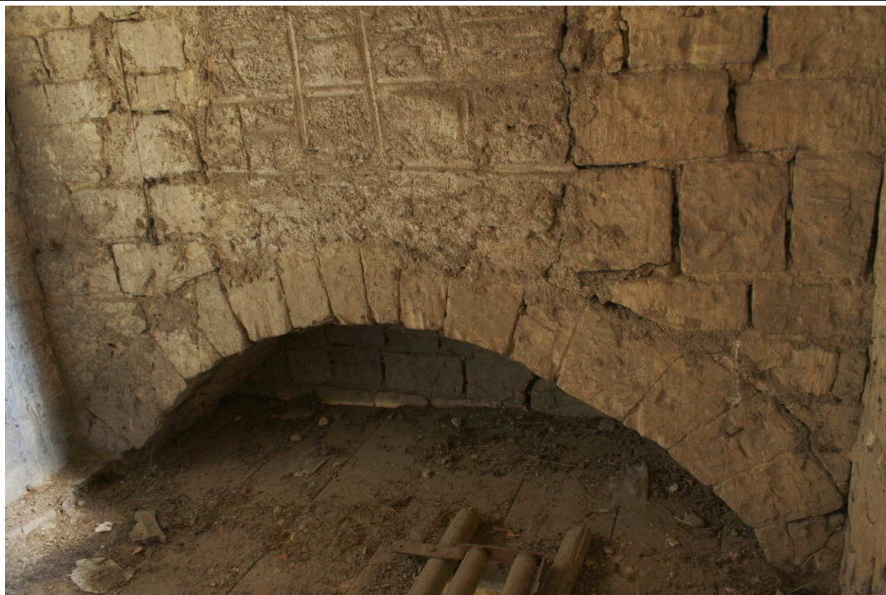
Pas v 2. patře věže vynášející východní stěnu věže v pohledu od jihozápadu. Foto: Jaroslav Skopec 2015.
