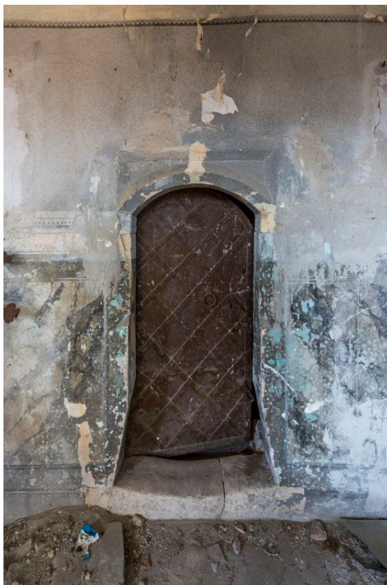
Portál vstupu do podvěží v pohledu od východu. Foto: Marta Pavlíková 2020.
