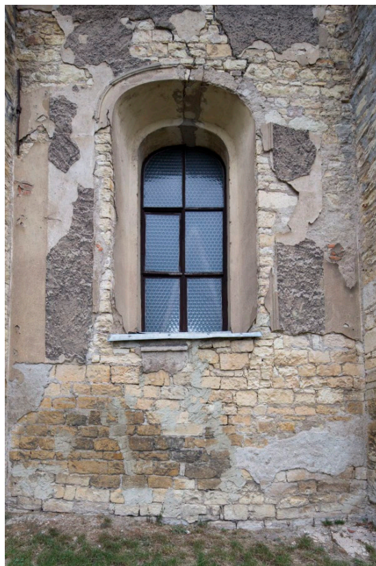
Detail zdiva jižní strany lodi mezi východním a západním opěrákem. Ve spodní partii fragment předpokládaného gotického zdiva užívajícího druhotně románské prvky. Foto: Marta Pavlíková 2014.
