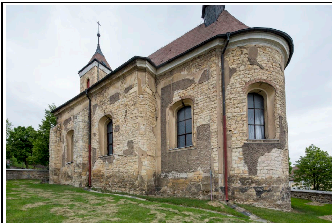
Celkový pohled od jihovýchodu. Foto: Marta Pavlíková 2014.
