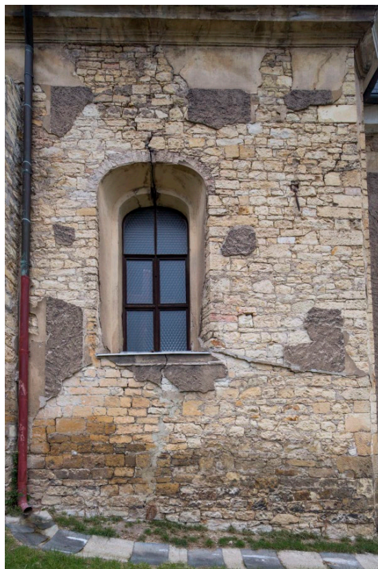
Detail zdiva jižní strany lodi mezi východním opěrákem a jihovýchodním nárožím. Ve spodní partii fragment předpokládaného gotického zdiva užívajícího druhotně románské prvky. Foto: Marta Pavlíková 2014.
